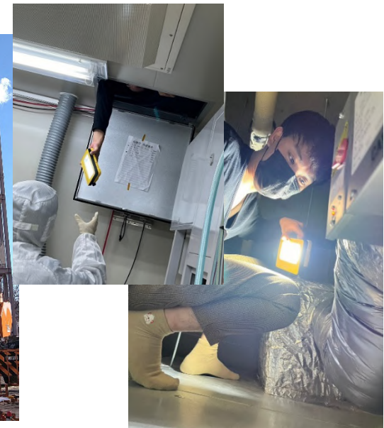
天井裏での作業
