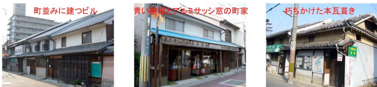
図 24. 町家の町並みの一例。
