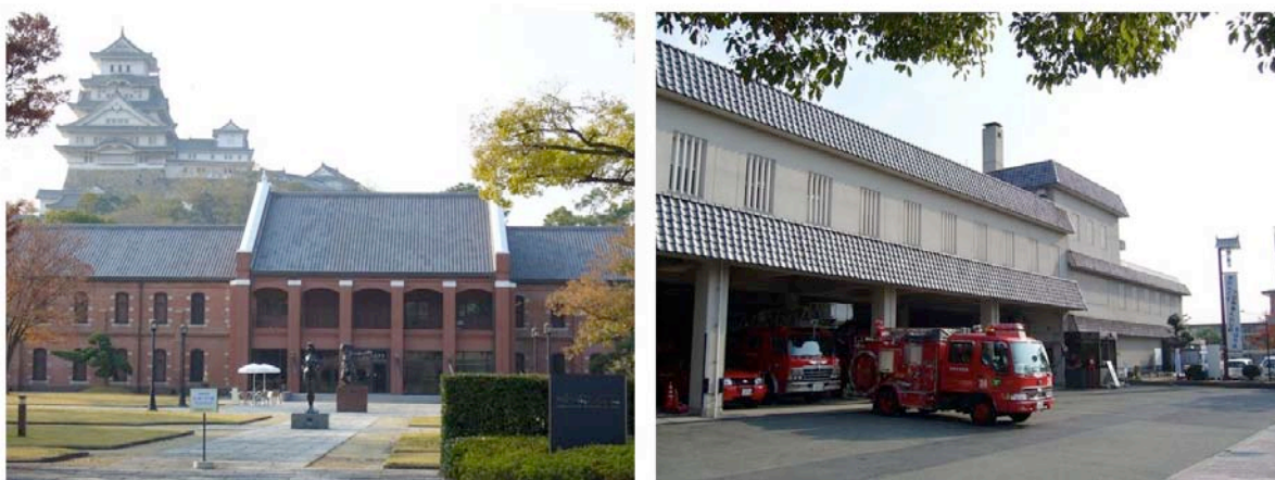
図23. いぶし瓦を施した公共建築物。（左：市立美術館，右：消防署）
